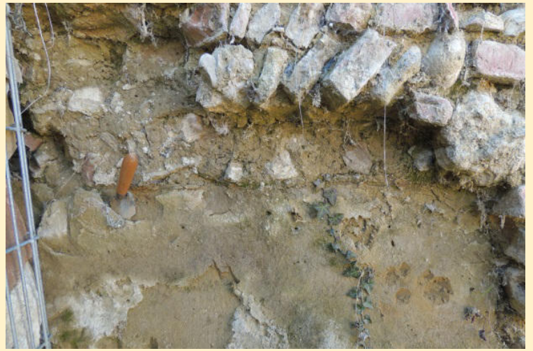
Figura 4. Muro a sacco costruito verosimilmente per convogliare l'acqua dentro la Fonte.
