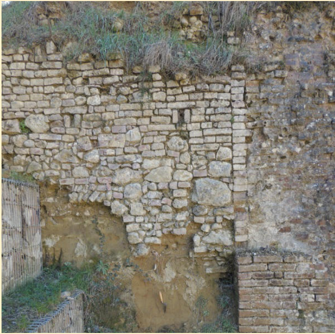
Figura 4. Muro a sacco costruito verosimilmente per convogliare l'acqua dentro la Fonte.
